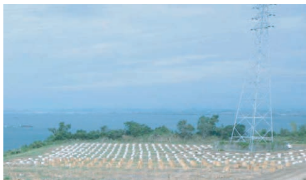
コンクリート基礎敷設状況
