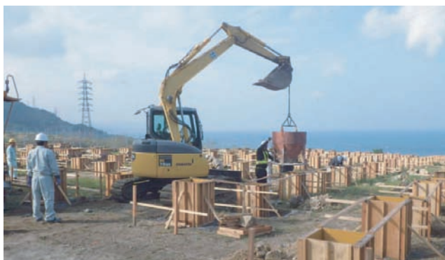
コンクリート打設（基礎工事）
