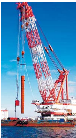
テーパー杭の施工状況
